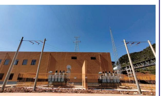
该总降压站的设计容量为25000千伏安，站内共配置两台主变压器，每台容量达12500千伏安。这两台变压器稳定承载着35KV的电压，并能将其高效的转换为10KV的电压，为整个项目的稳定运行提供了坚实的电力支持。
